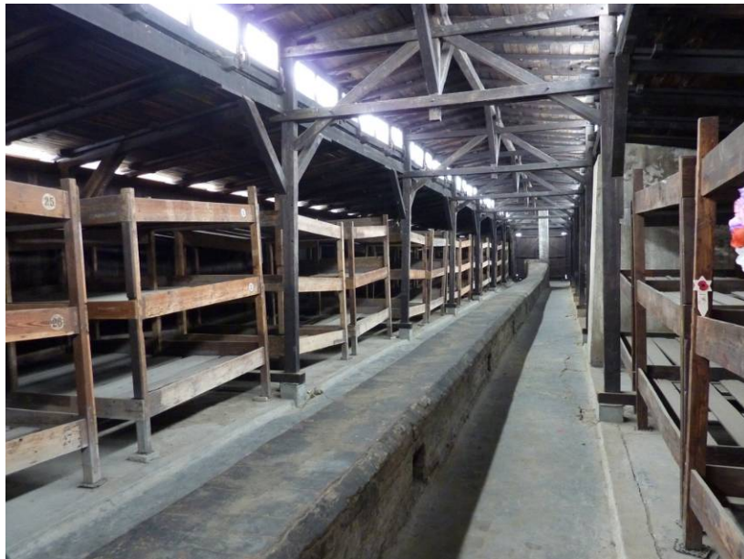
Intérieur d'un block.
