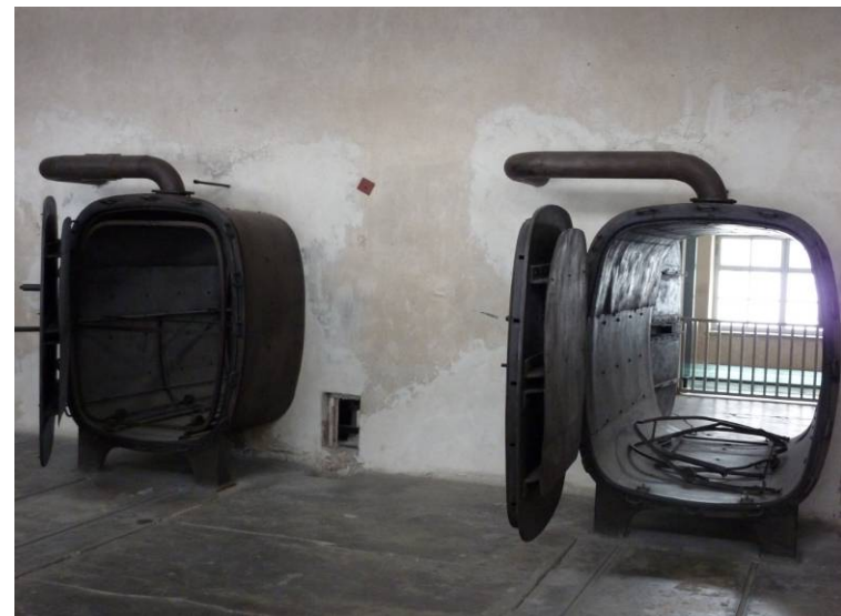
Cuves de désinfection pour les vêtements.
